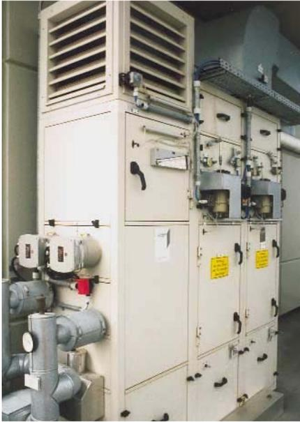
**Ex-Kanalluftheritzer 30 kW für Klimaanlage**
